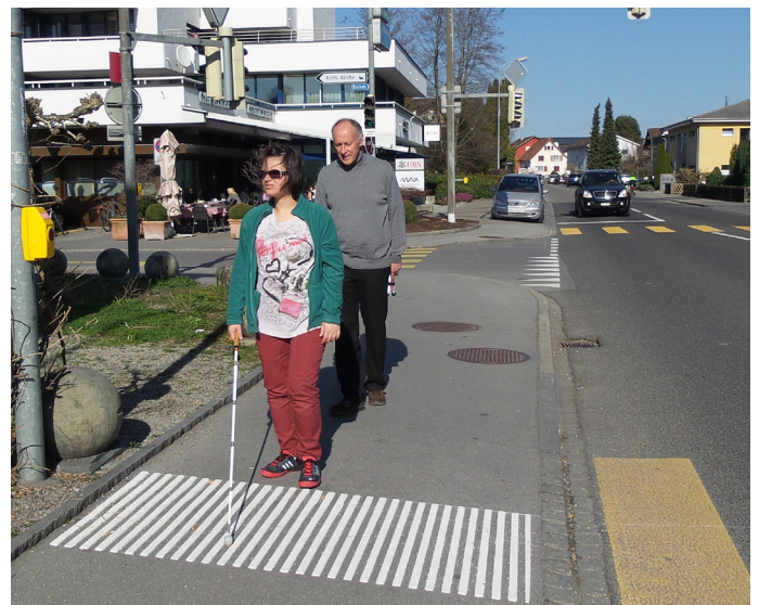
Dank den neu angebrachten Aufmerksamkeitsfeldern können Sehbehinderte die Strassen sicherer überqueren.
