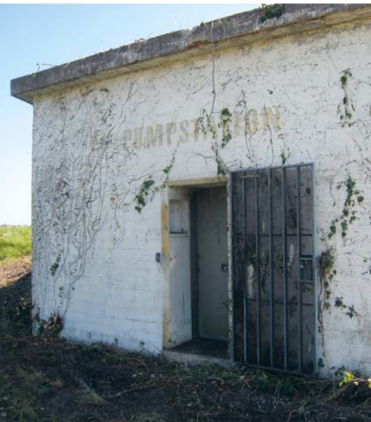
Bild: Jakob Hensel «Bunker getarnt als Pumpstation»
