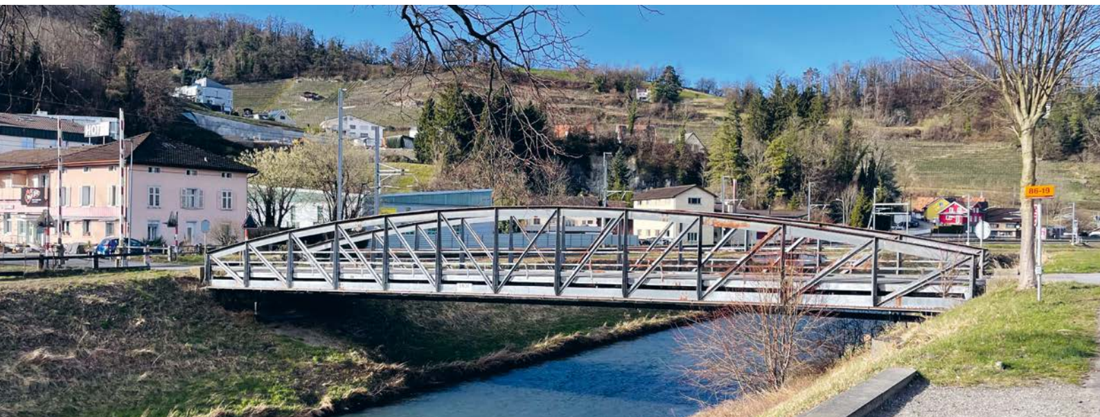
Binnenkanal Au, Brücke Bahnhof Au
