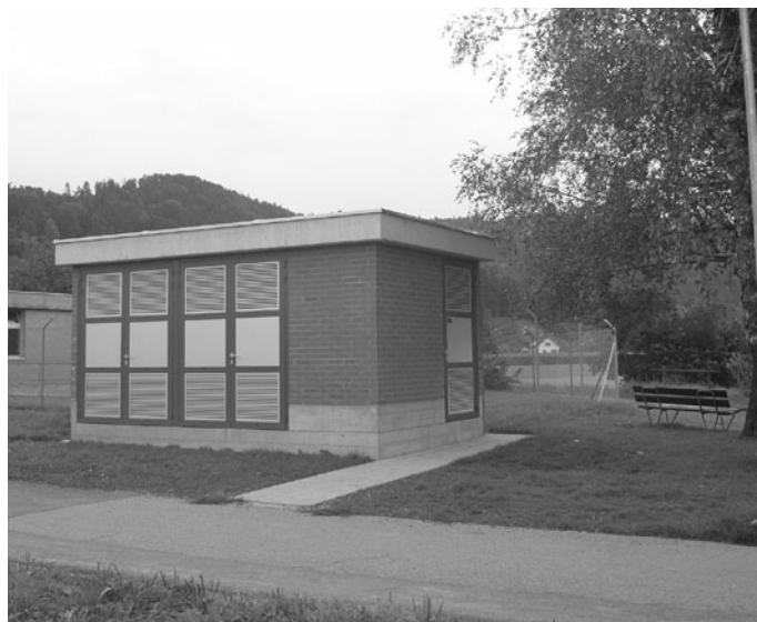
neue Trafostation «Kloteren»
