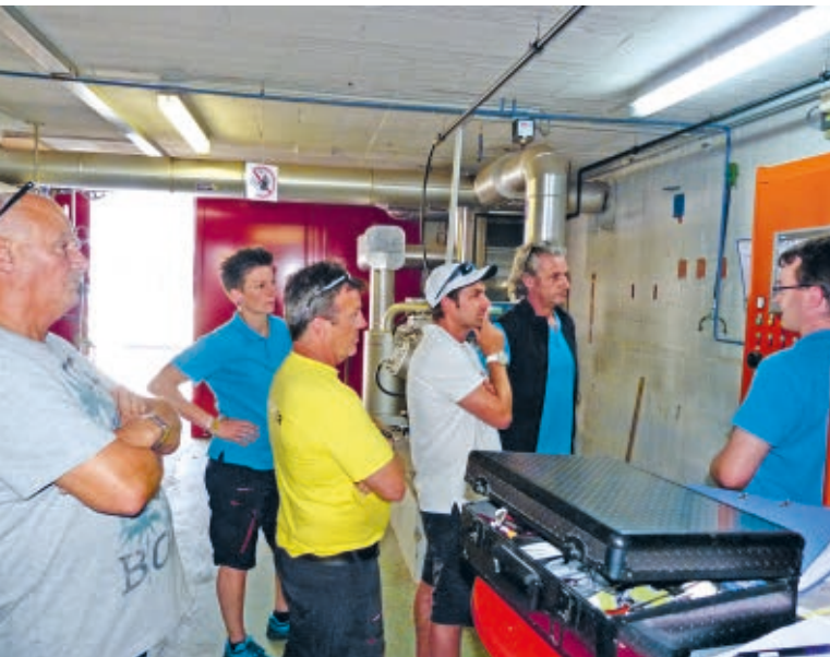
Schulung neue Kältesteuerung
