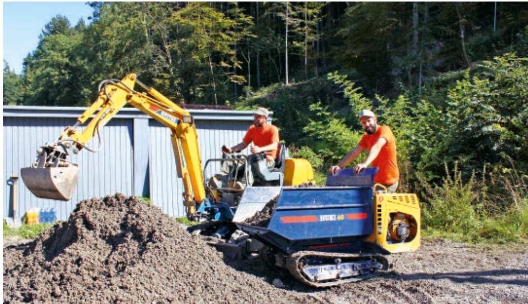
Der letzte Wiederholungskurs der RZSO Rheintal. Im Wiederholungskurs 2019 wurden Arbeiten zu Gunsten der Gemeinden und Bevölkerung gemacht (Bild Berneck, Schlossenriet, Instandstellungsarbeiten).
