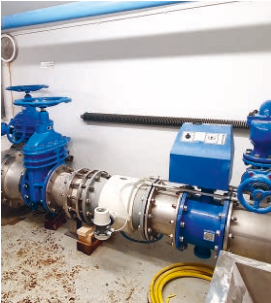
Hümpeler Sanierung Wanddurchführung
