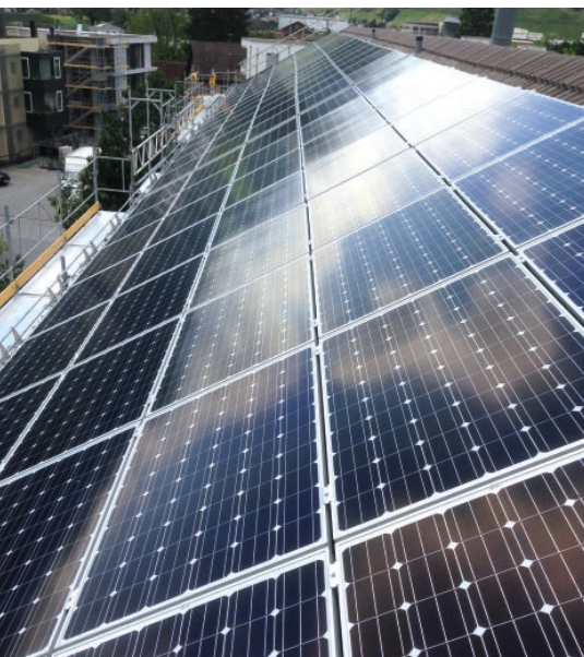
Photovoltaikanlage auf dem Dach des Werkhofgebäudes
