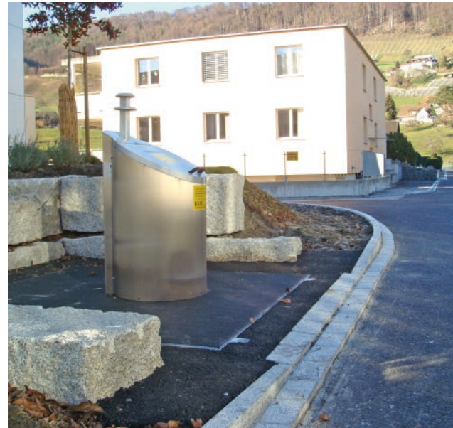
Unterflurcontainer, Weesstrasse Au
