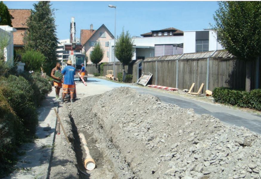
Sanierungsarbeiten an der Rietstrasse
