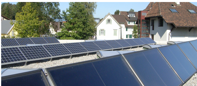
Photovoltaik- und Solaranlage Turnhalle Wees
