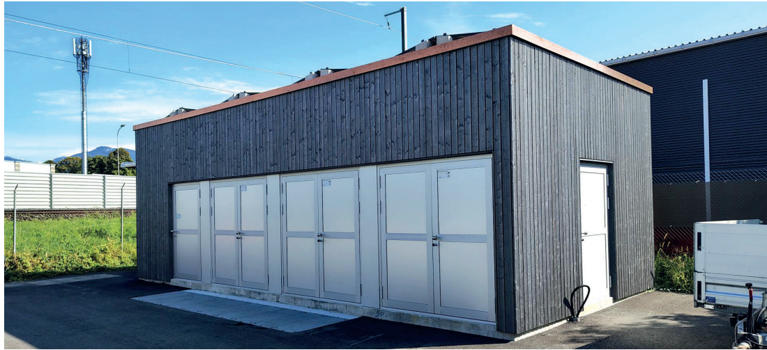
Transformatorstation TS 39 Werkhof, Au
