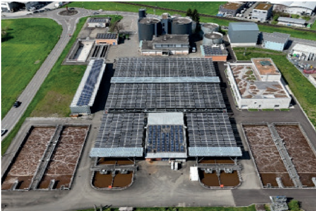
Abwasserwerk Rosenbergsau, Au
