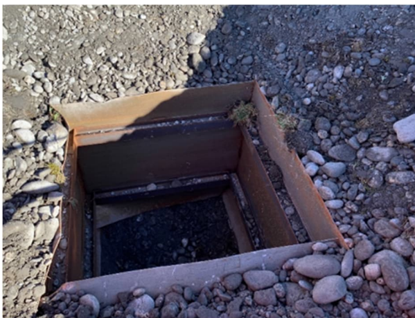
Abbildung 1 Beispiel Aushubabstützung mittels Stahlblech
