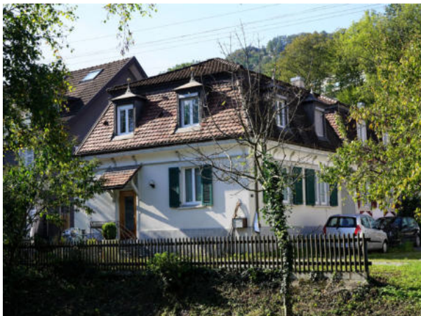
Ansicht Haus Nr. 17 von Süden
