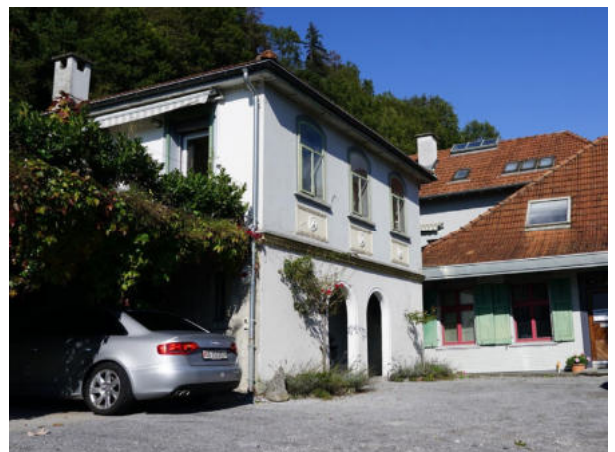
rückwärtiger Hofraum mit Nebenbaute Ass. Nr. 2
