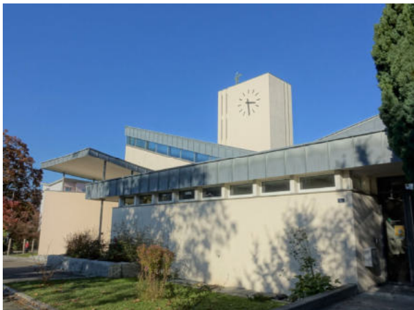
Ansicht Gesamtanlage aus Südwest
