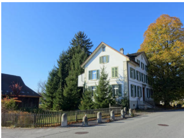
Gesamtsituation mit Nebengebäude auf dem Grundstück
