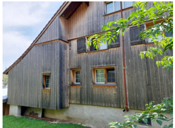
Details rückwärtige Fassade
