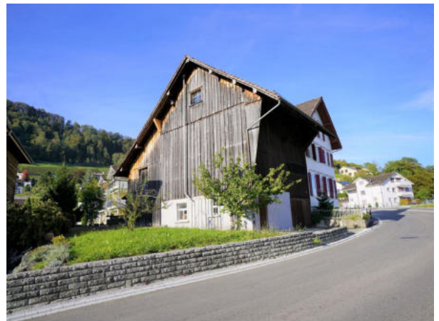
Gesamtansicht von Westen
