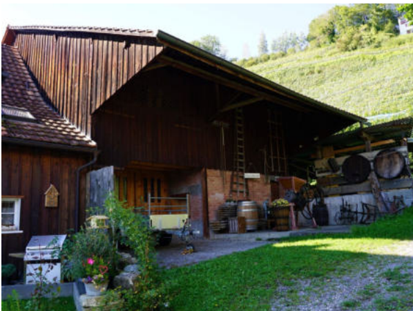
rückseitig angebaute Scheune Ass. 1267
