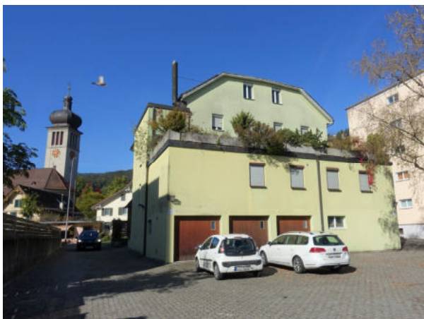
rückwärtige Ansicht mit Blickrichtung alter Ortskern
