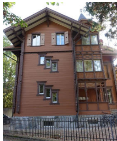
westseitige Fassade unter Quergiebel, Turmaufbau über Eingang
