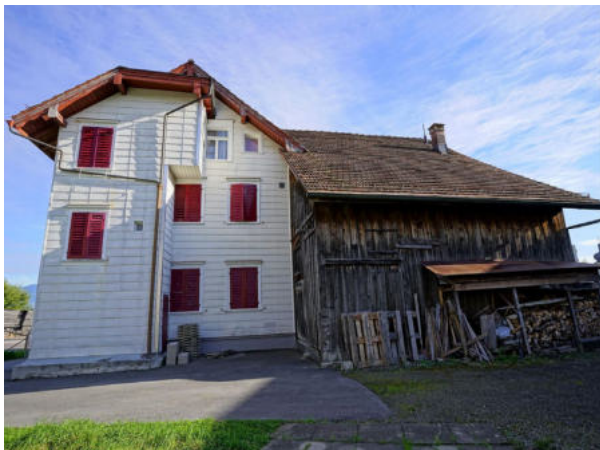
rückwärtige Fassade mit Anbau
