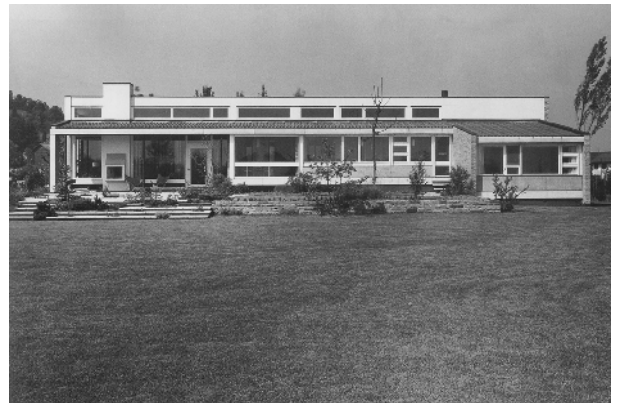
historische Aufnahme kurz nach Erstellung
