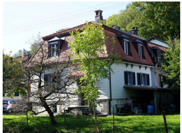
Ansicht Haus Nr. 13 von Süden
