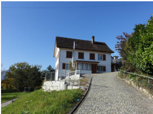
Situierung am Gässeliweg, Ansicht von Osten
