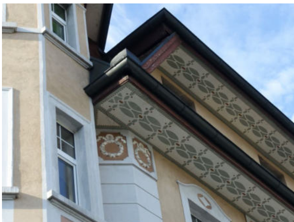
Verzierte Dachuntersichten und weitere Zierelemente
