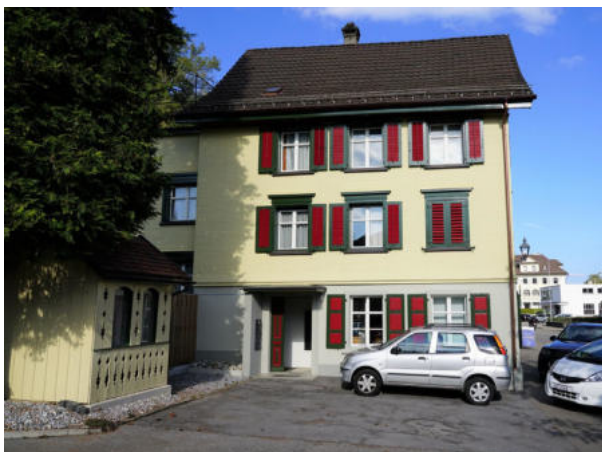
Westfassade mit Vorplatz und Gartenhaus
