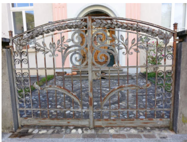
Aufwändig verziertes Gartentor vor dem Haupteingang
