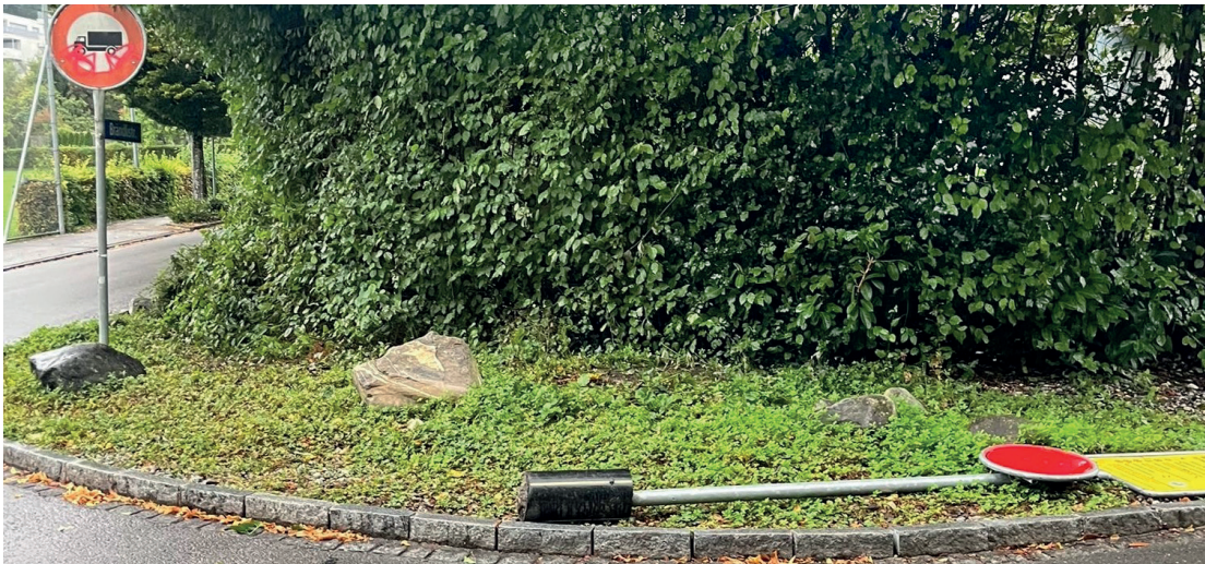
Ausgerissene und beschmierte Signalisationstafeln
