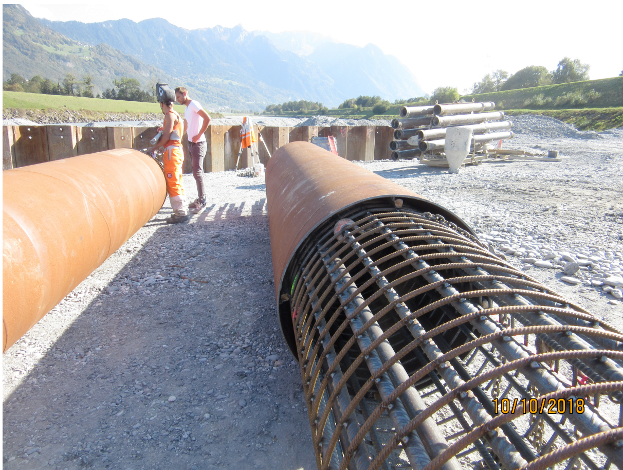
Bild 15 Einbau abrasionsfester Bohrpfähle am Alpenrhein für die Lastabtragung an einer Brücke (Quelle: Casutt Wyrsh Zwicky dipl. bauingenieure und planer)
