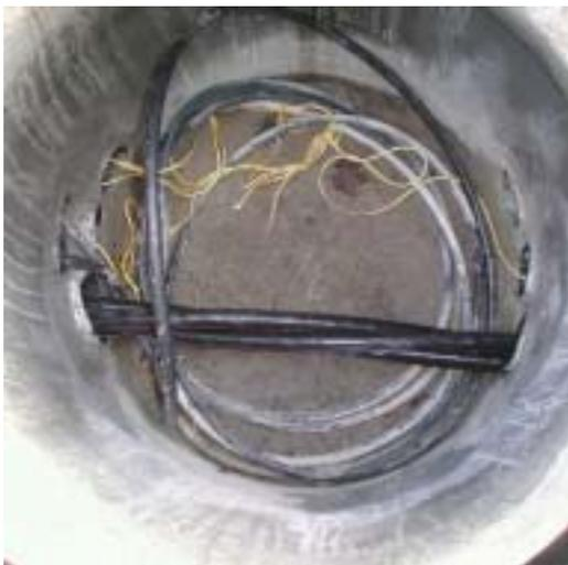
Die Rohre sind ca. 5 bis 10cm über dem Schachtboden einzuführen und bündig abzuschneiden. Die Durchführung ist von Innen wie auch von Aussen sauber mit Beton zuzuputzen.
